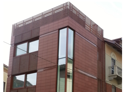
RISTRUTTURAZIONE IN TORINO CORSO FERRUCCI
